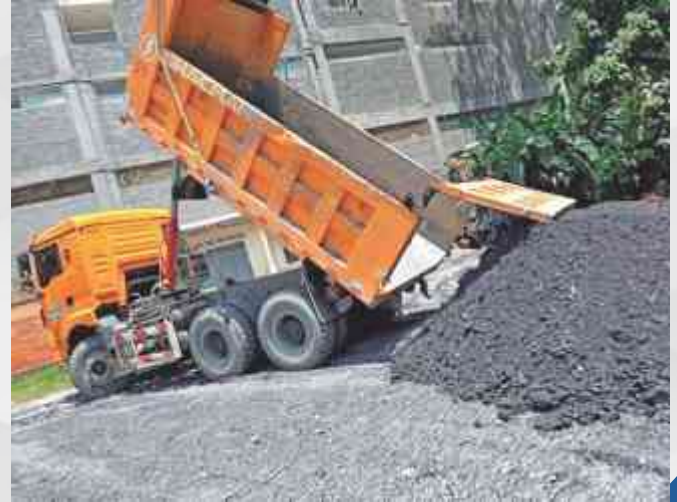
Material de pizarra donado para la nivelación topográfica
