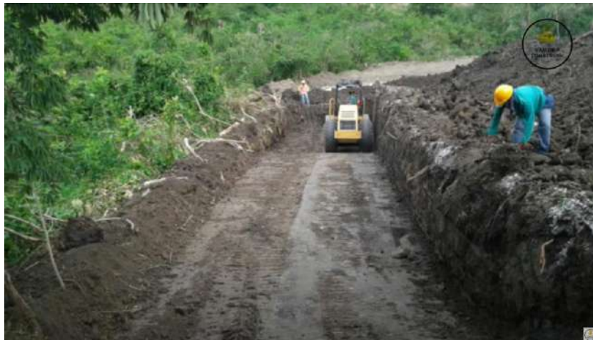
Figura 3.75 Ejemplo de preparación y compactación del terreno
