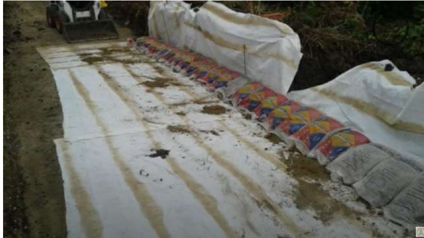
Figura 3.78 Encofrado de fachada
