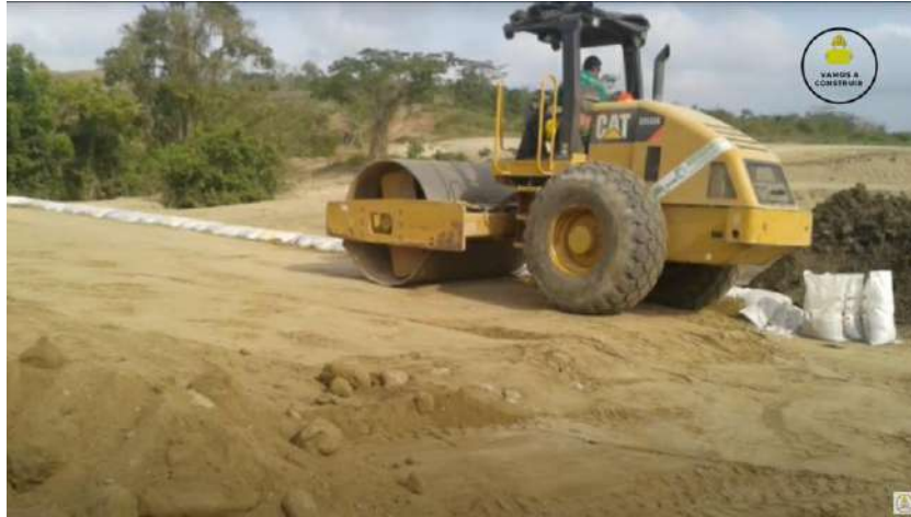
Figura 3.82 Compactación del terreno
