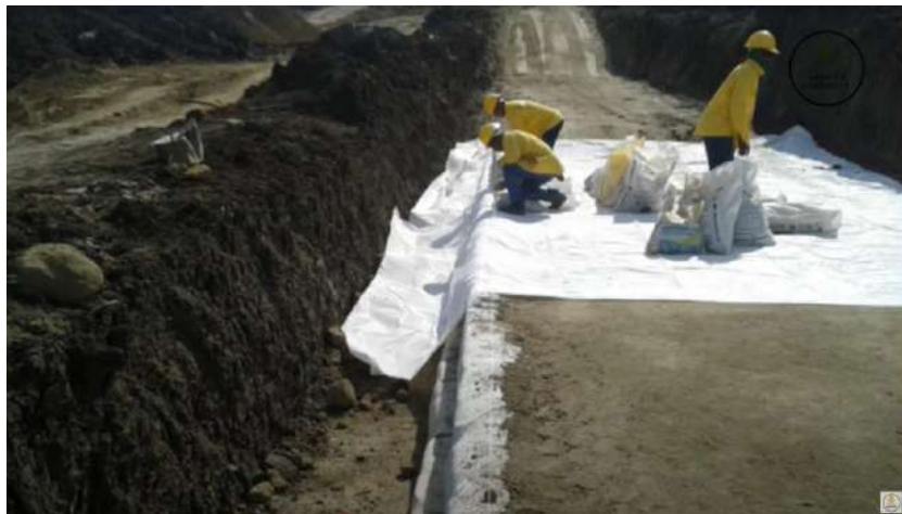
Figura 3.77 Instalación de geotextil en obra
