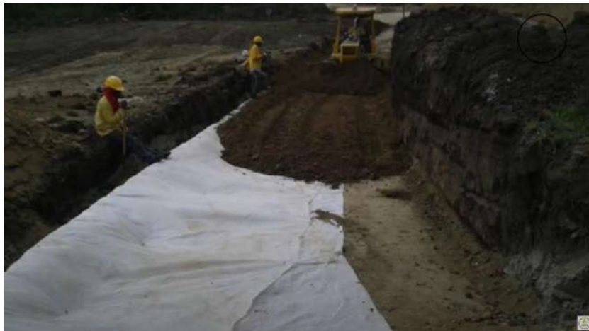
Figura 3.81 Conformación de la capa de relleno Fuente: Tomado de Vamos a construir- Obras civiles ( https://www.youtube.com/watch?v=eFlpMeBEgOA )
