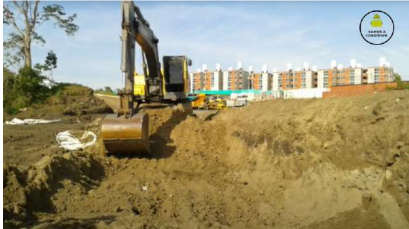
Figura 3.74 Ejemplo de excavación en obra
