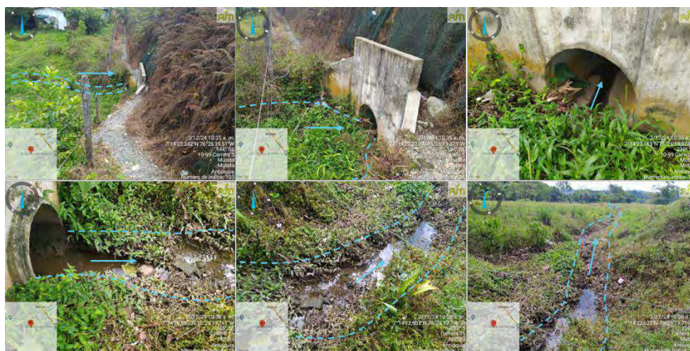
Fotografía 5.40 Características del cauce – Drenaje Sin Nombre 1
