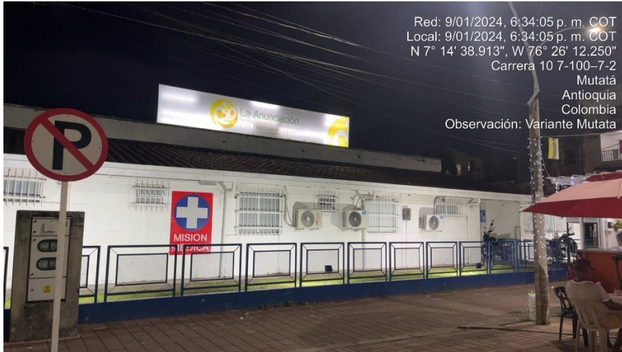
Fotografía 5-1 Hospital de municipio de Mutatá Fuente: Alternativa Ambiental S.A.S, 2024
