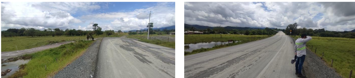
Fotografía 7.5 Zona cercana al empalme Autopista Mar 2 – Jaguey
